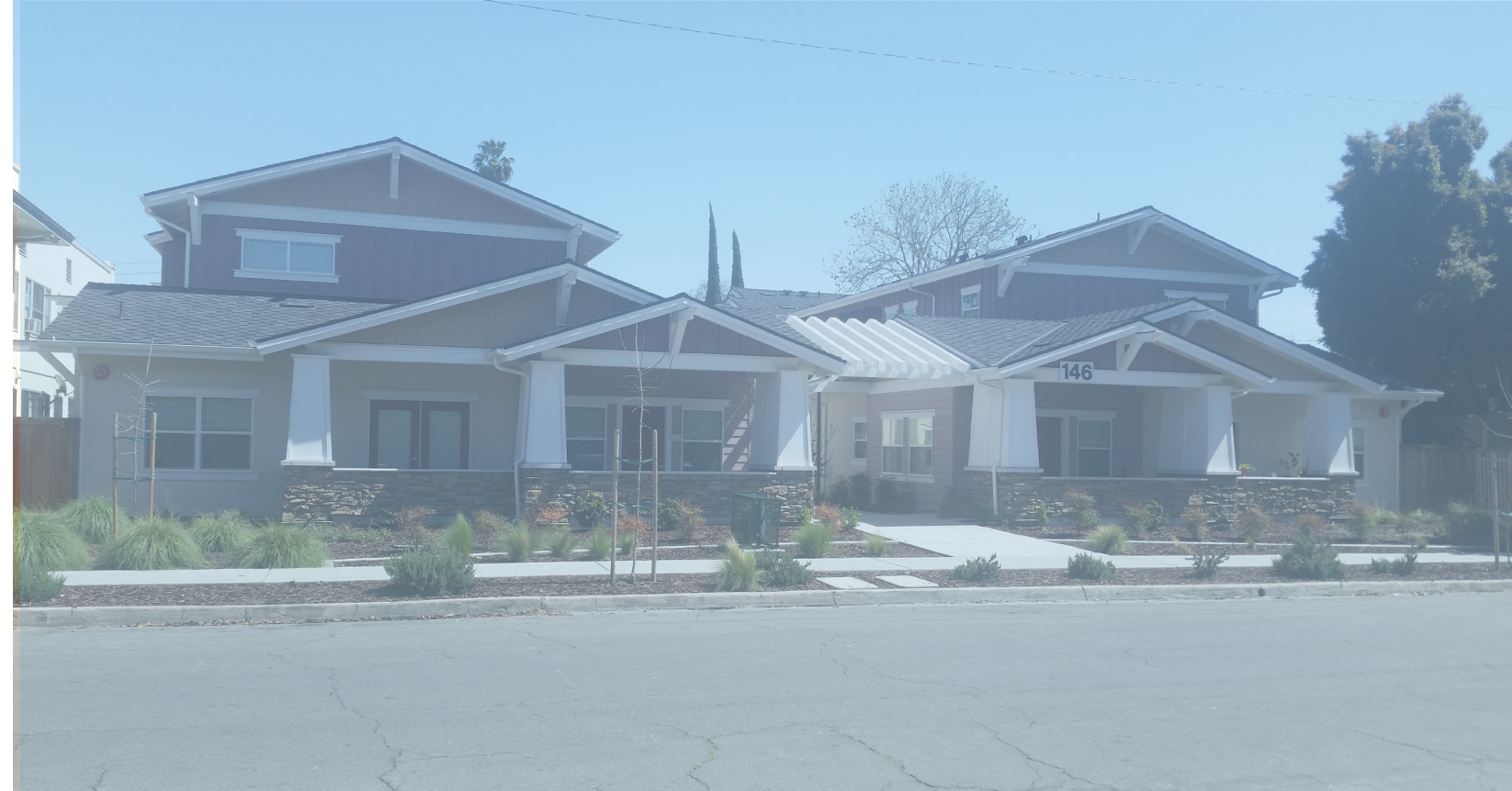
1406 N. Glenn HOME Project
